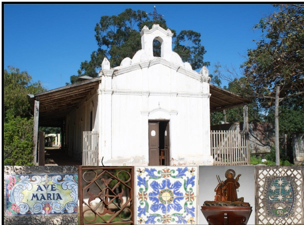
Capilla de Misión Tacaaglè y detalles de su arquitectura.
