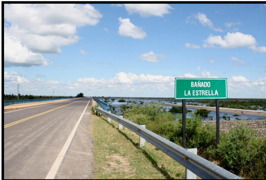
Puente y ruta Provincial N°28. (Actual)
